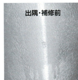
出隅・補修前 → 出隅・補修後 出隅の傷も上記と同様の方法で補修して、自然に乾燥すればほとんど分らないで補修出来ます。
