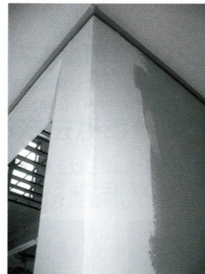
出隅処理完成
