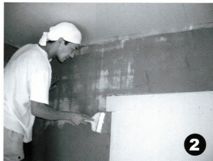
お好み焼きのヘラのようなもので、塗り壁を剥がします。
