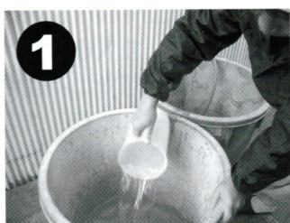
基準水量の全量をバケツに入れる
