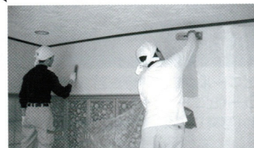
下地が完全乾燥したことを確認したら、メルシーシリーズを施工します。
