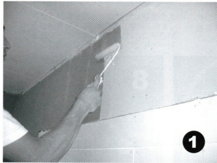
塗り壁の上に剥離剤を塗って、塗り壁を剥がしやすくします。
